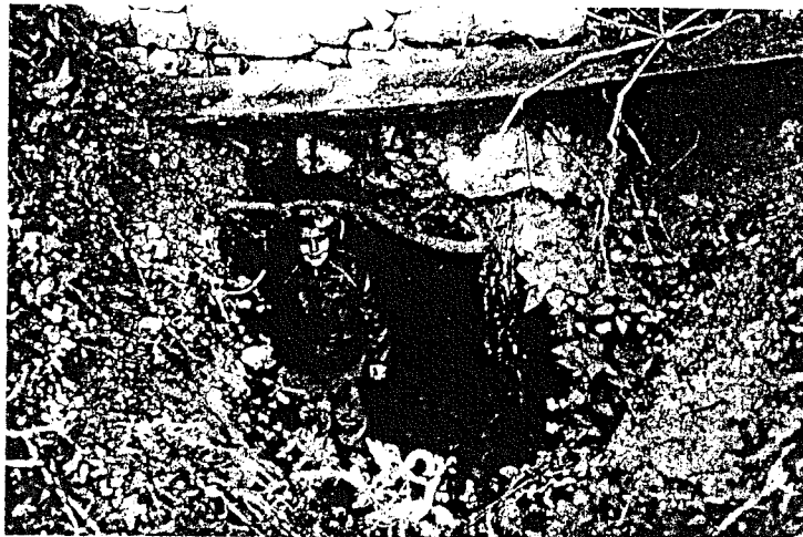
A Guimps, l'un des sujets traités : une cheminée d'aération d'un souterrain sur la propriété de M. Tard et que nous montre le jeune David (Photo « S-O », Maurice Boulin)
